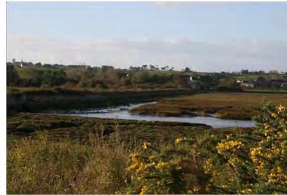
Digue et clapets de l'estuaire de la Flèche dans la baie de Goulven
