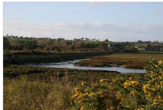
Digue et clapets de l'estuaire de la Flèche dans la baie de Goulven
